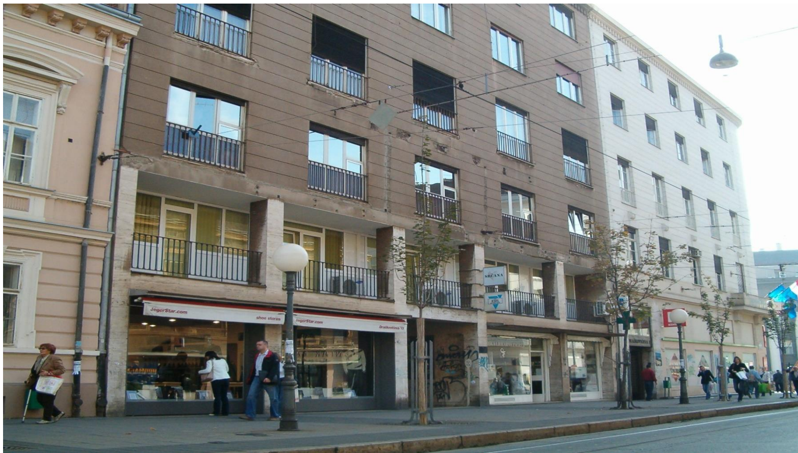
Zgrada Poliklinike Srčane u Draškovićevoj ulici (1424 m 2 )
